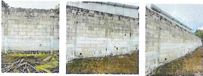
Foto1: Simientos de muro perimetral a flor de tierra
