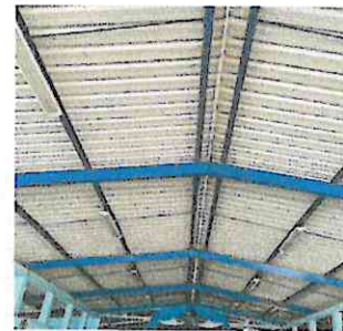
Foto 4: Sustitución de Lámparas
